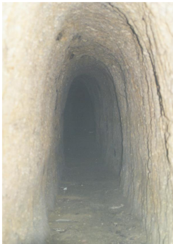
Photo n°30. Intérieur du souterrain des Forêts
