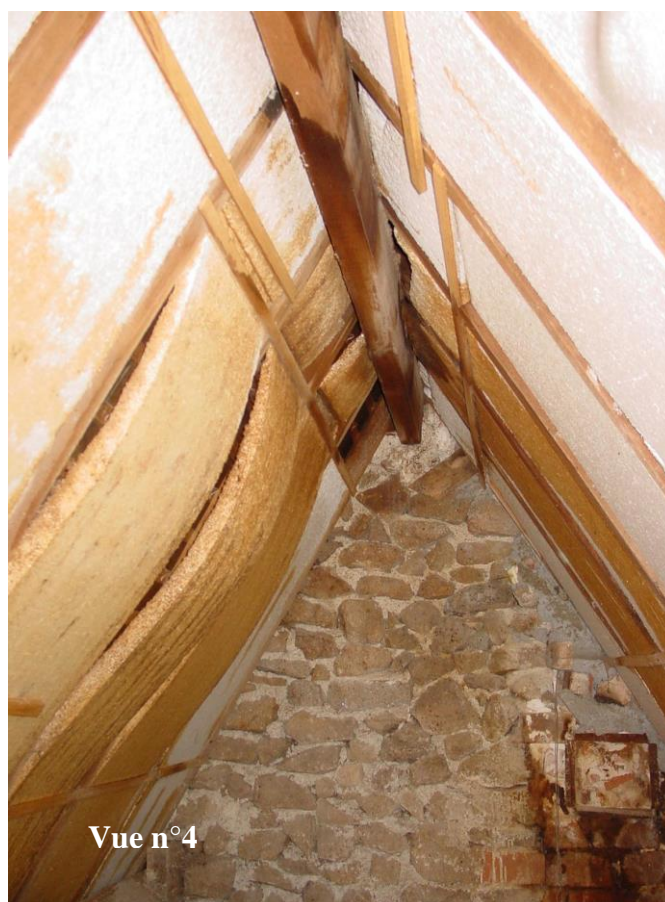
Photo n°52. Arrière du pignon orienté vers le nord
