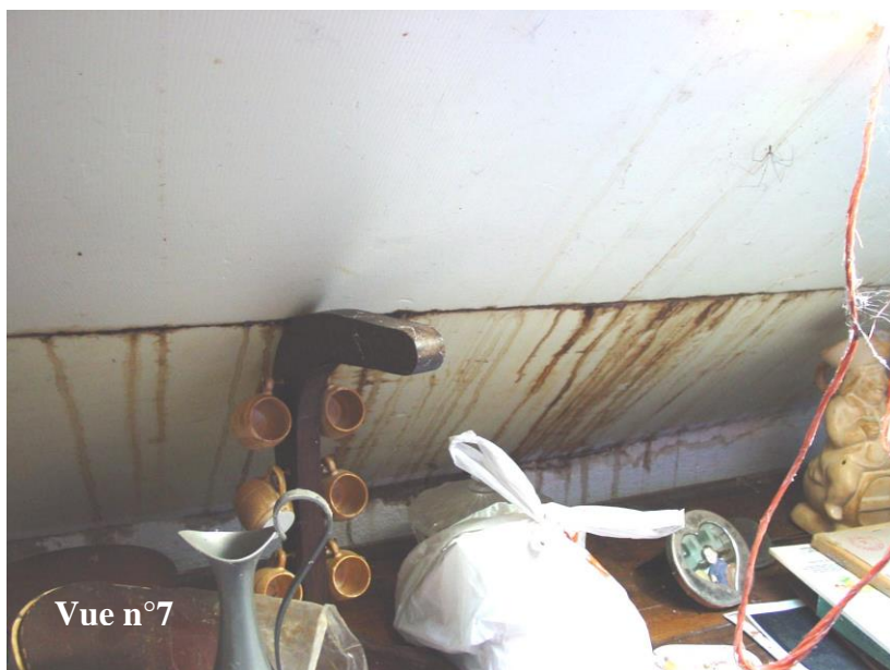
Photo n°55. Dégradations occasionnées sur les plaques de polystyrène extrudé (bas des combles)
