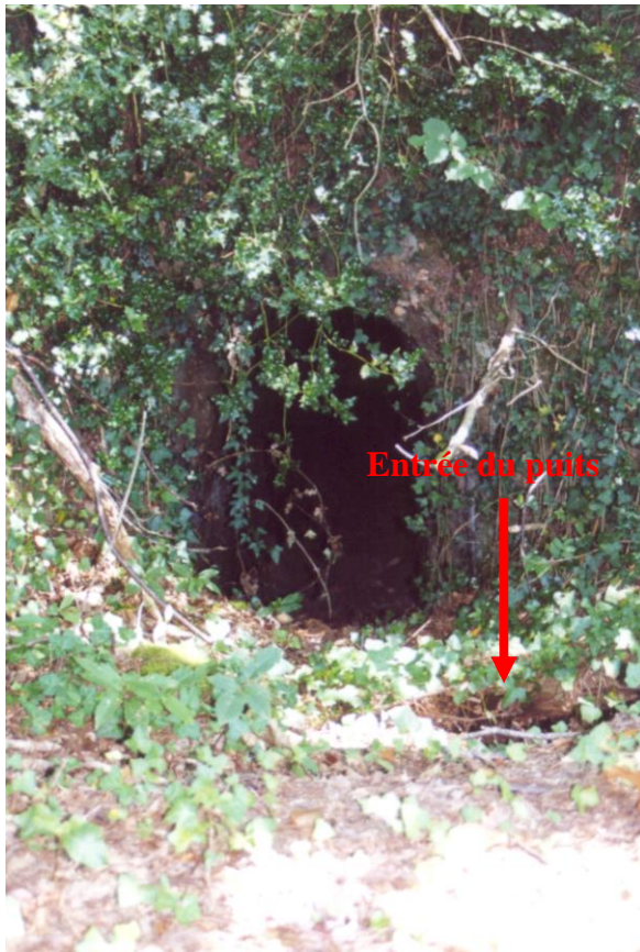
Photo n°31. Entrée du souterrain de Laurière
