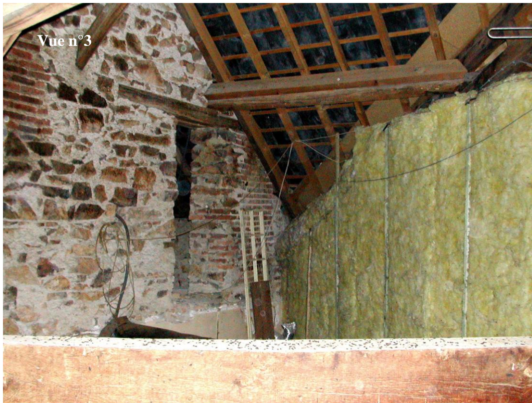
Photo n°46. Vue de la partie gauche aménagée
