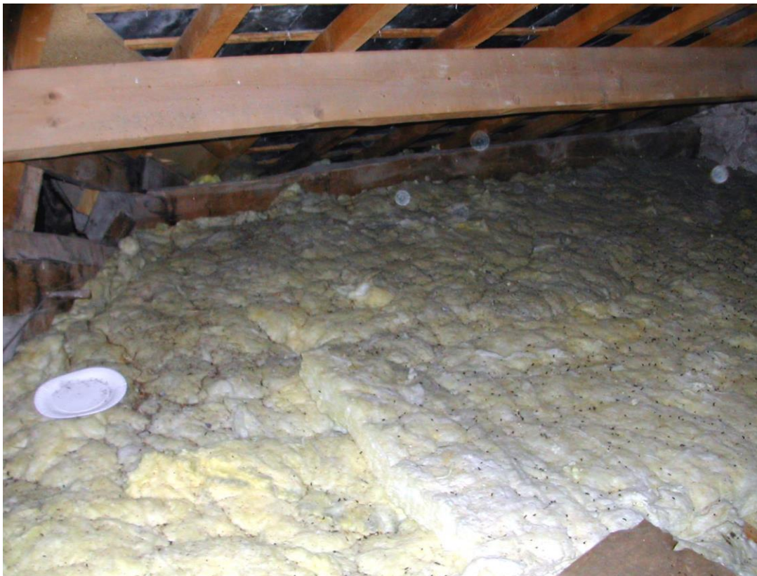
Photo n°47. Guano tombé sur la laine de verre couvrant le haut de la partie aménagée
