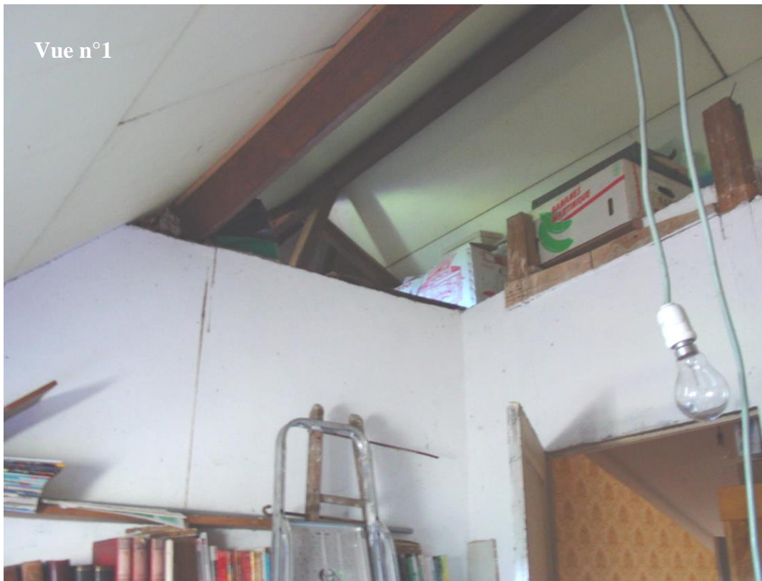
Photo n°49. Accès à la partie non aménagée des combles
