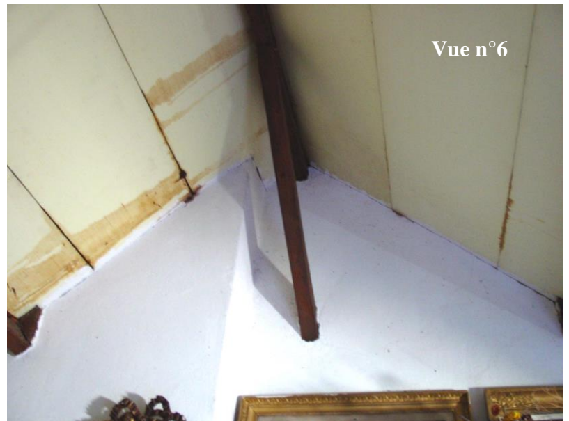
Photo n°54. Dégradations occasionnées sur les plaques de polystyrène extrudé (haut des combles)
