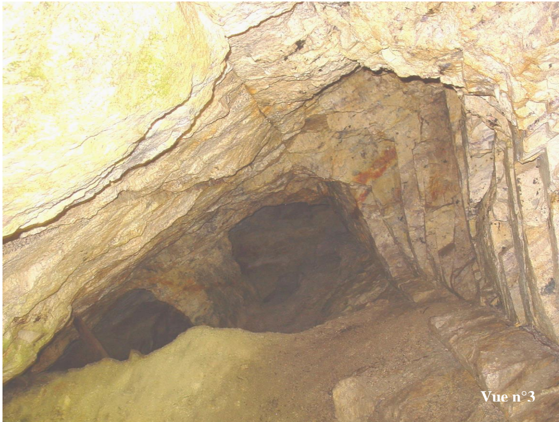
Photo n°19. Vue générale de la première galerie
