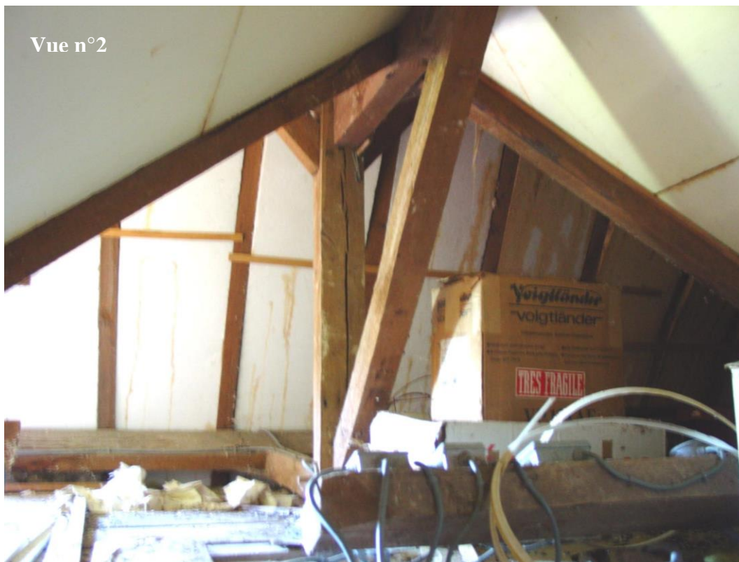
Photo n°50. Partie haute des combles
