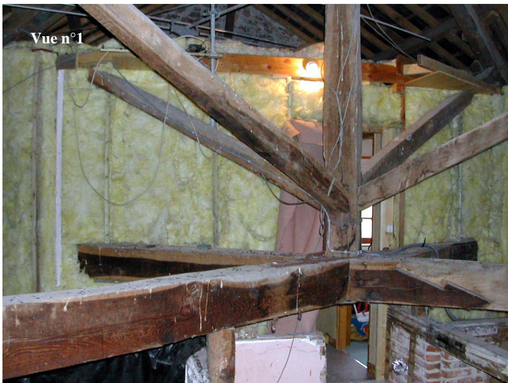
Photo n°44. Vue de la partie aménagée de face
