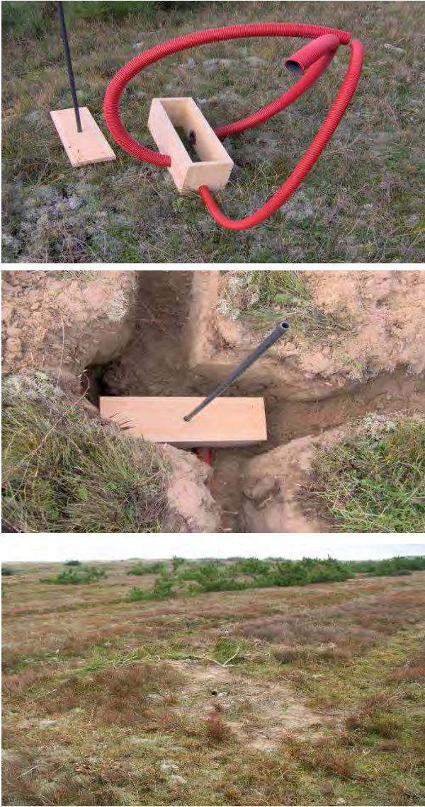
Fig. 17 : Mise en place de gîtes artificiels (Photos : Pierre Grillet).
