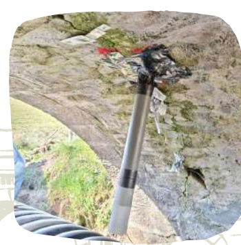
Système anti-retour permettant l'évacuation de l'individu mais pas son retour
