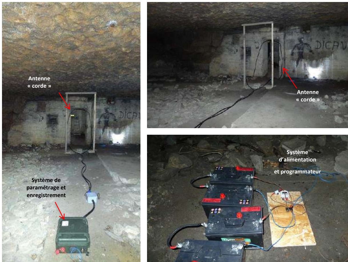
Figure 3 : « Antenne corde » installée à Saint-Michel-le-Cloucq (85) (M. LEUCHTMANN)
